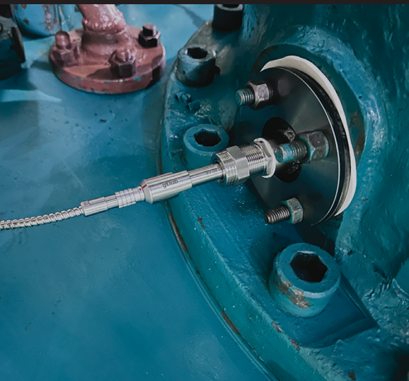
Установка радиальных вихретоковых датчиков на нагнетатель ГПА
