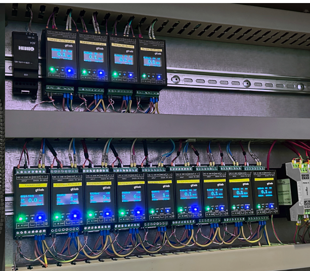
Монтаж контроллеров A636 в САУ ГПА МСКУ – СС4510
