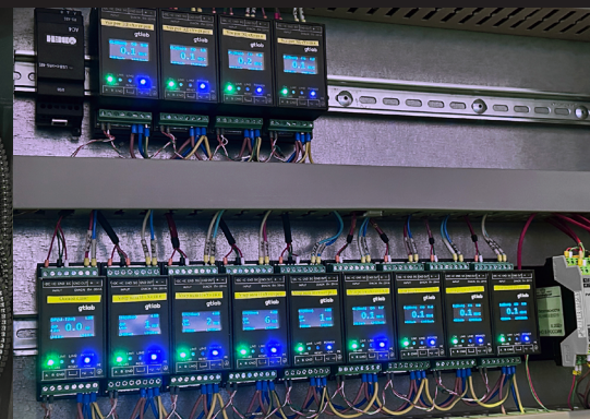
Монтаж контроллеров A636 в САУ ГПА МСКУ – СС4510
