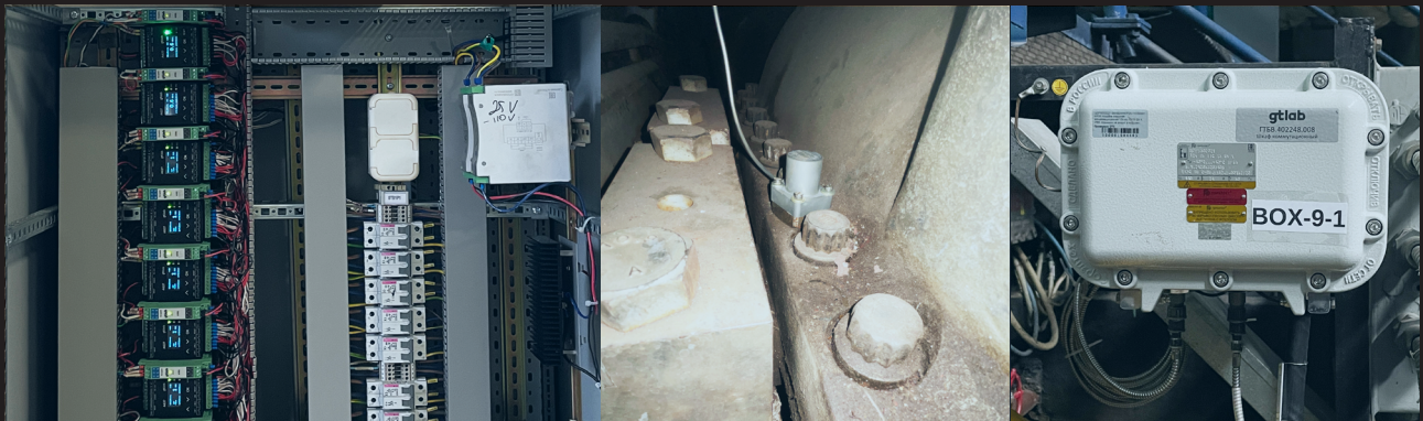
Монтаж контроллеров А637 в САУ
