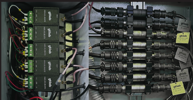
Монтаж вихрековых формирователей A301 во взрывозащищенном корпусе
